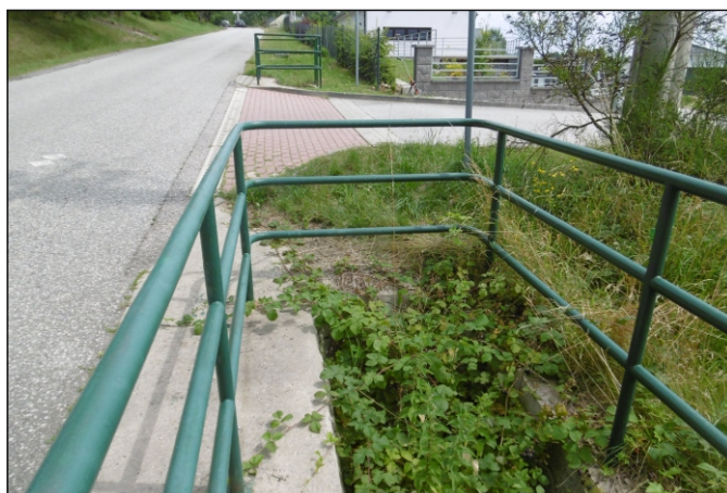
Propustek 1d - staničení 0,001 - pohled zprava
