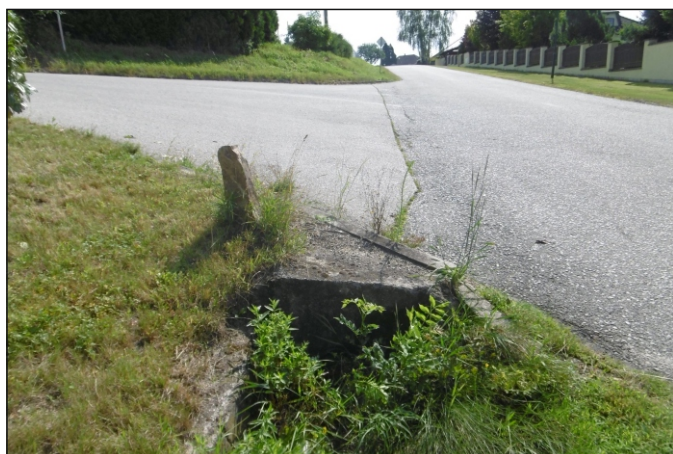
Propustek 2c - staničení 0,001 - pohled zleva
