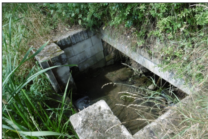
Most 8c-M1 - staničení 1,110 - pohled zleva
