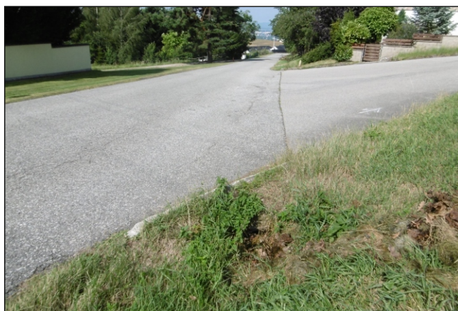
Propustek 2c - staničení 0,001 - pohled zprava
