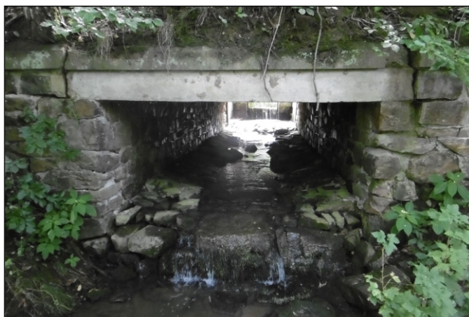
Most 8c-M1 - staničení 1,110 - pohled zprava
