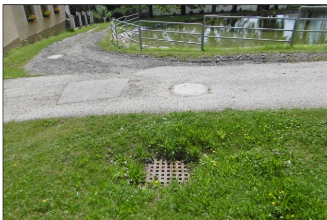
Propustek 6c - staničení 0,134 - pohled zleva
