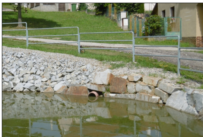
Propustek 6c - staničení 0,134 - pohled zprava
